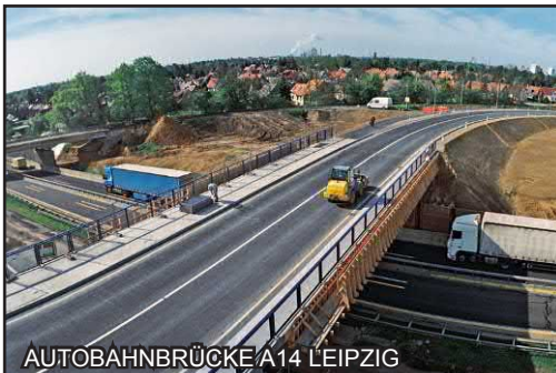
AUTOBAHNBRÜCKE A14 LEIPZIG
